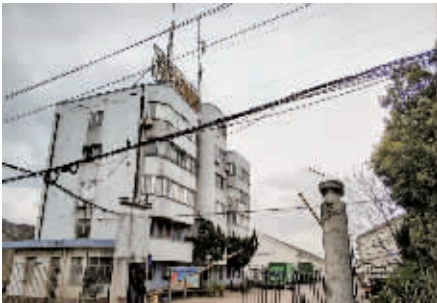
拆除前的白沙粮库。 董浩 摄
