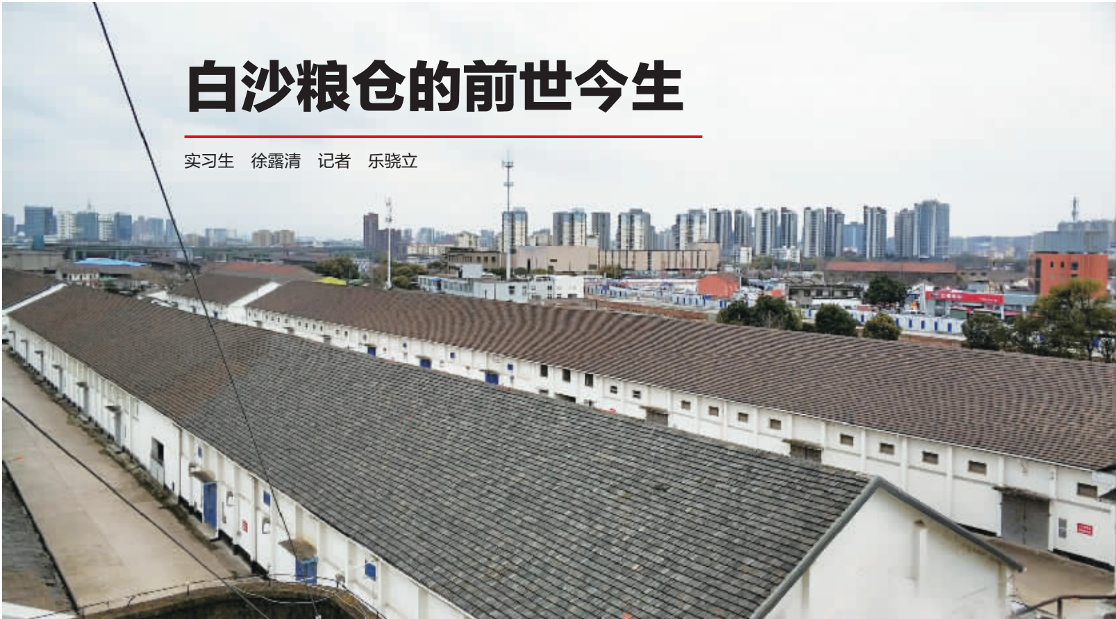
拆除前的白沙粮库。 董浩 摄
