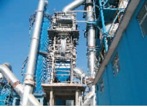
▲图为瀛洲水泥废气余热发电窑头锅炉。
