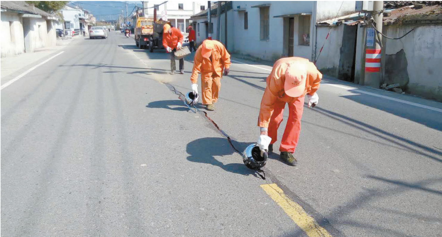
“人勤春来早，养护正当时”。春季是多种公路病害的易发季节。今年一开春，区公路部门就抓住春暖花开的好时机，撸起袖子加油干，全面开展公路春季养护。图为路面灌缝现场。
