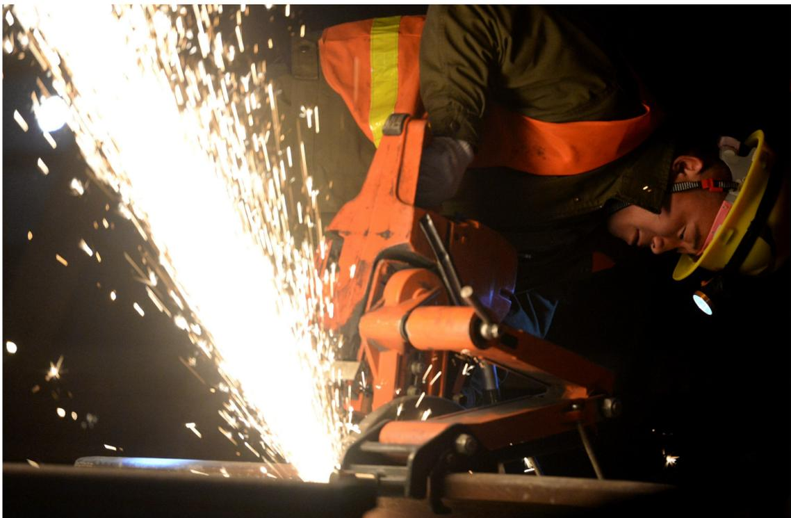
4月6日，施工人员在宝兰高铁宝鸡南站进行钢轨切割作业。当日凌晨，随着宝兰高铁最后一段钢轨铺设完毕，顺利接入宝鸡南站，宝兰高铁全线轨道铺设任务全面完成，为全线按期开通奠定了坚实基础。
