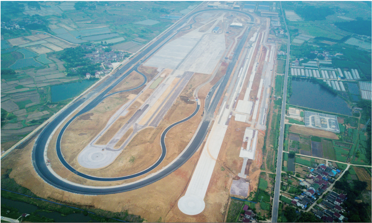
4月25日拍摄的建设中的江苏南京福特试车场高速环道。4月下旬，江苏南京福特试车场高速环道弯道段沥青摊铺完工，这座“中国造”试车场高速环道即将亮相投运。
