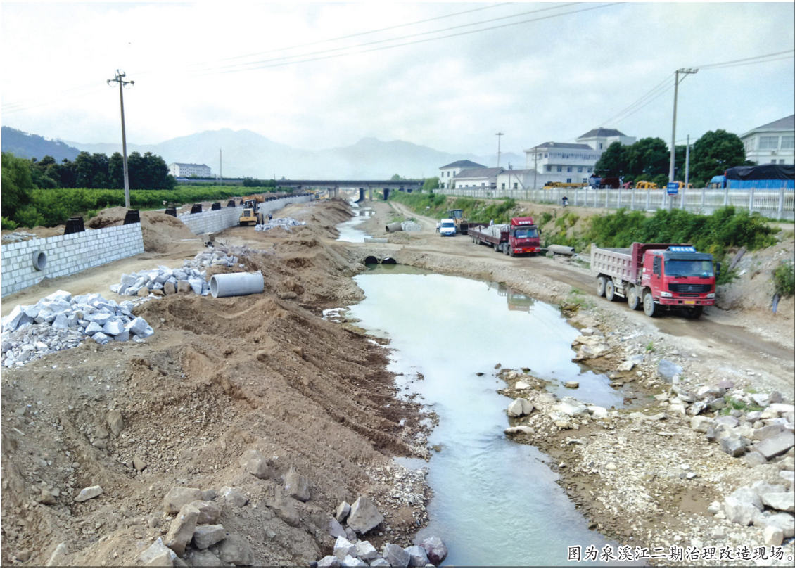
图为泉溪江二期治理改造现场。
