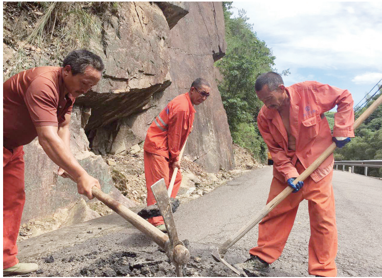
大堰公路管理所养护人员在溪南线挖掘拥包
