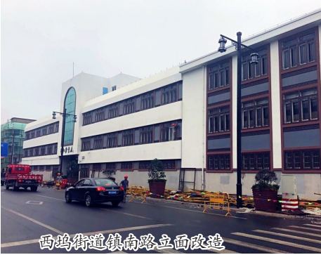
西坞街道镇南路立面改造
