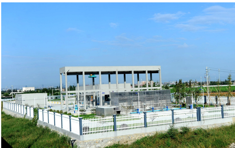
方桥污水管网工程I标段
