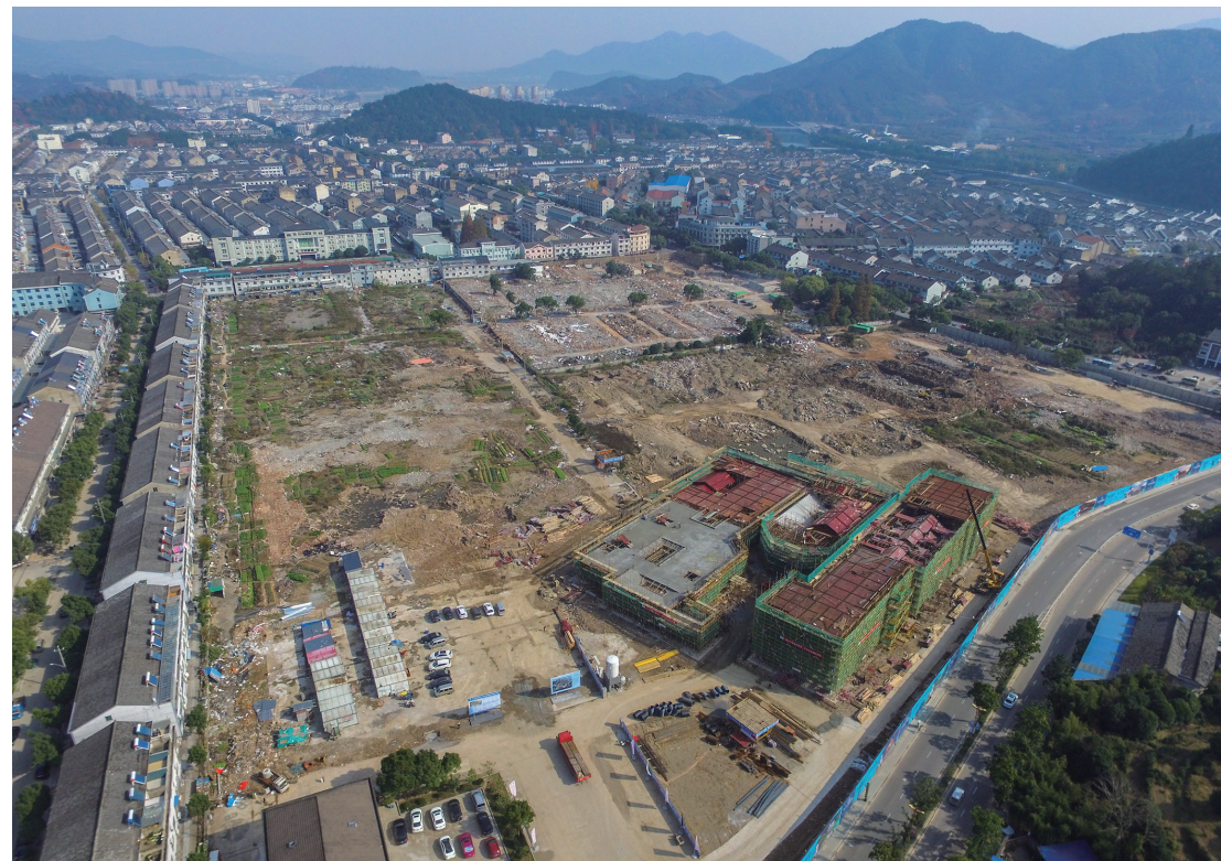
民国风情街建设工地鸟瞰图
