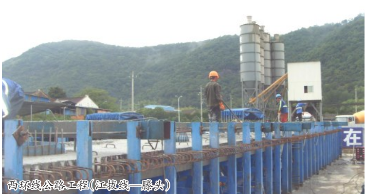
西环线公路工程(江拔线—滕头)
