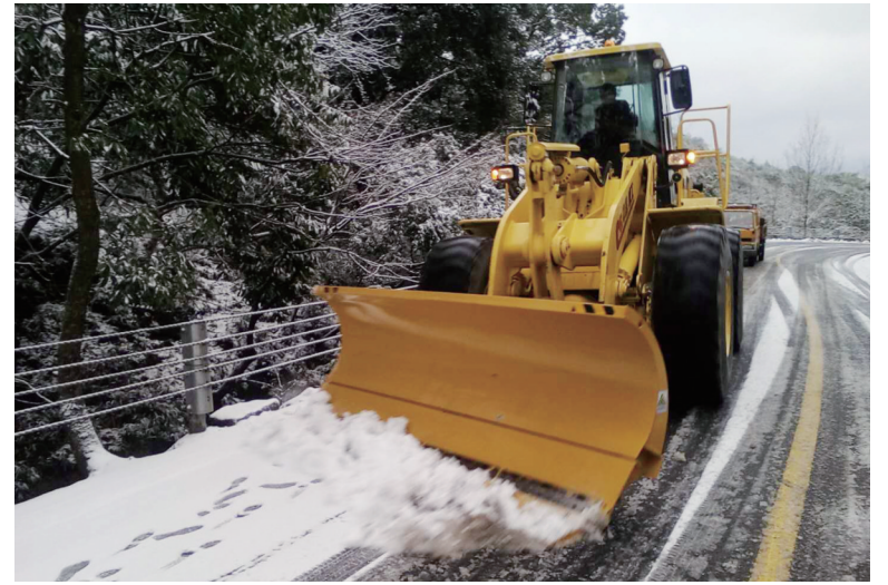
浒溪线抢险作业进行中
