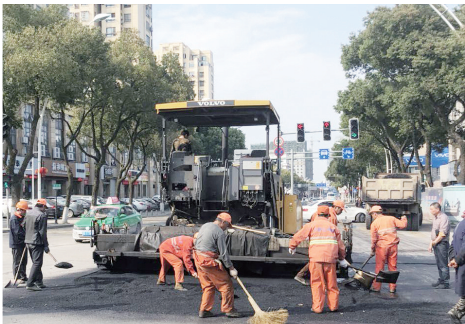
区园林处对南山路解放桥“桥头跳车”现象进行整改
