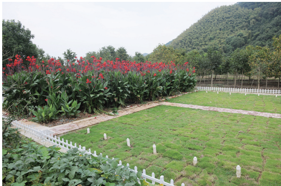
农村污水处理站
