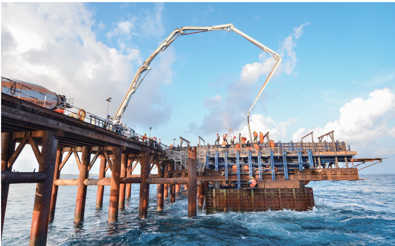
中马友谊大桥是两国在共建21世纪海上丝绸之路领域的标志性项目。大桥全长2千米,连通马尔代夫首都马累和机场岛,设计使用寿命100年。大桥建成后,环马累生活和居住圈将形成,有助于疏解马累岛居住压力,游客则能通过陆路实现马累与机场岛之间的快速往返。 新华社发
