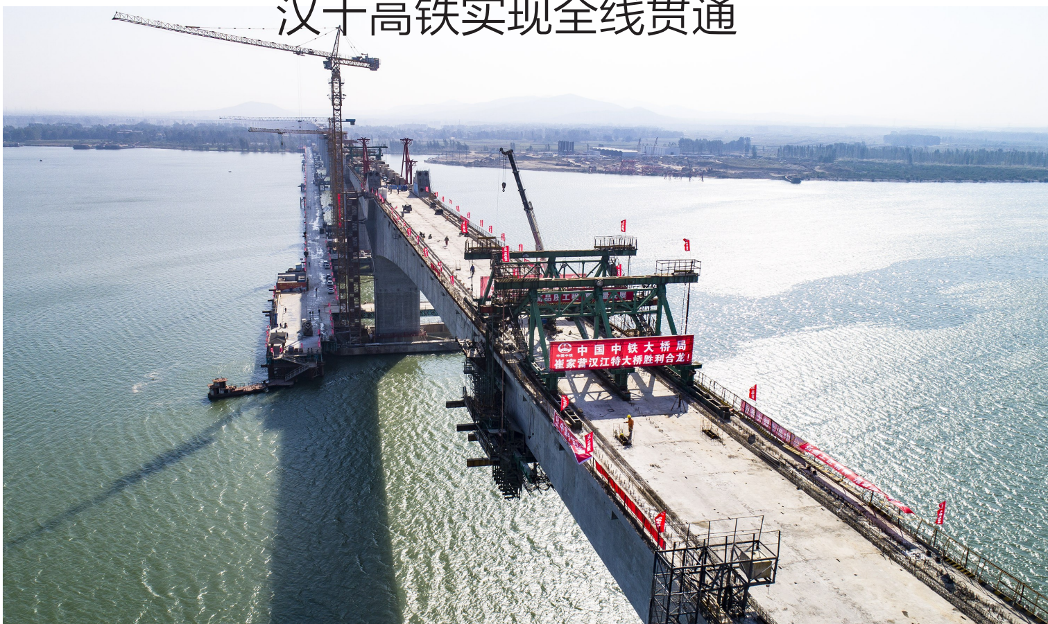
10月12日,崔家营汉江特大桥顺利合龙(无人机拍摄)。
