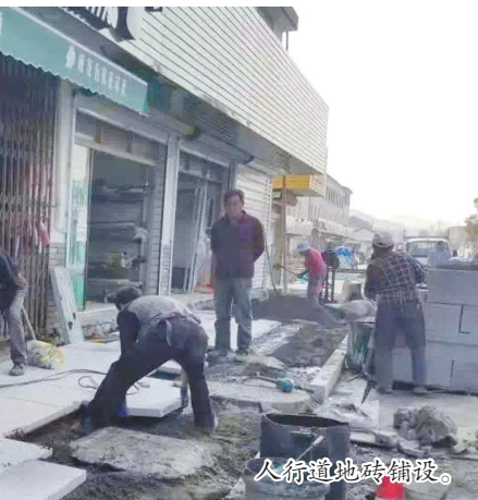
银河路沥青路面摊铺。
