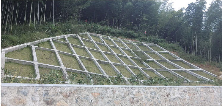
西堡寺地质灾害点治理后的现状
