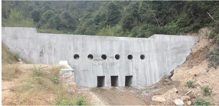
西峰寺地质灾害点治理后的现状
