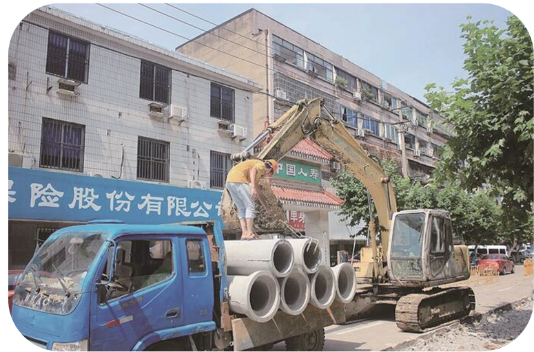
污水零直排工程
