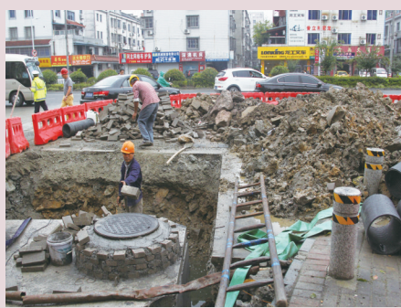
金钟路沿线污水支管建设工程现场
