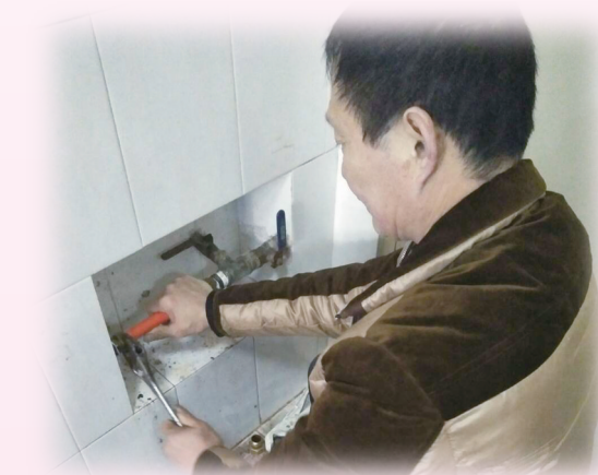
春节期间免费上门维修水管
