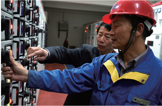
亚太物业中央花园设备检修保养
