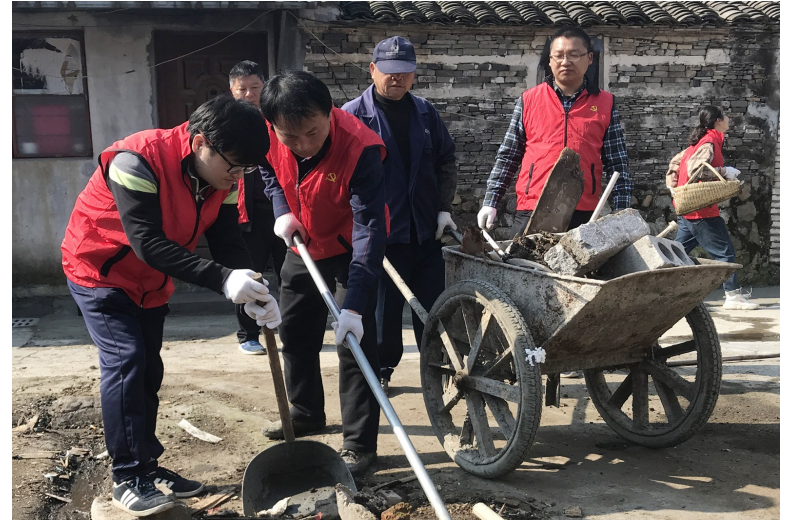
自蕪湖镇打响小城镇环境综合整治百日攻坚战以来,全镇上下始终坚守一线,确保完成各项节点目标,加班加点,推动工程施工进度。同时,加大宣传力度,引导群众积极参与整治。图为党员干部与村民在杨家村共同参与环境整治。
