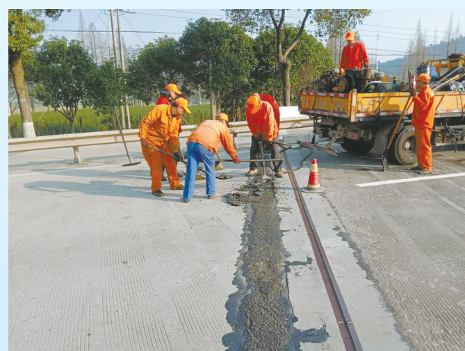
溪南线路面施工
