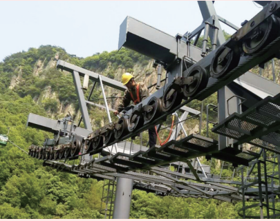
工作人员每天对特种设备进行安全检查
