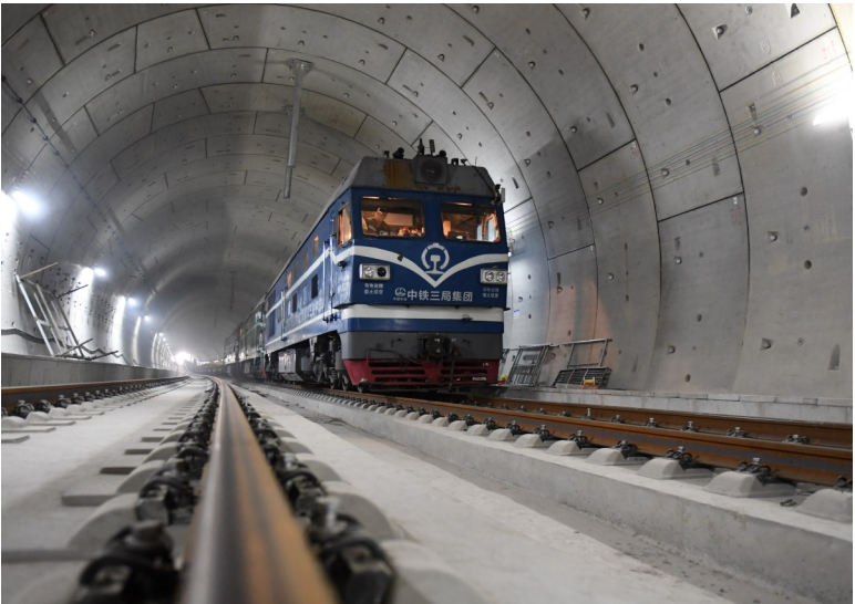
6月12日拍摄的铺轨完成后的京张高铁清华园隧道。
