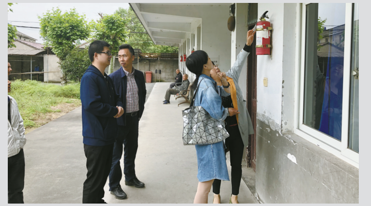
在西坞敬老院检查消防设备
