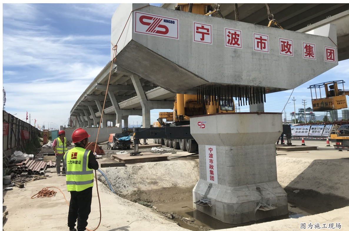
图为施工现场
