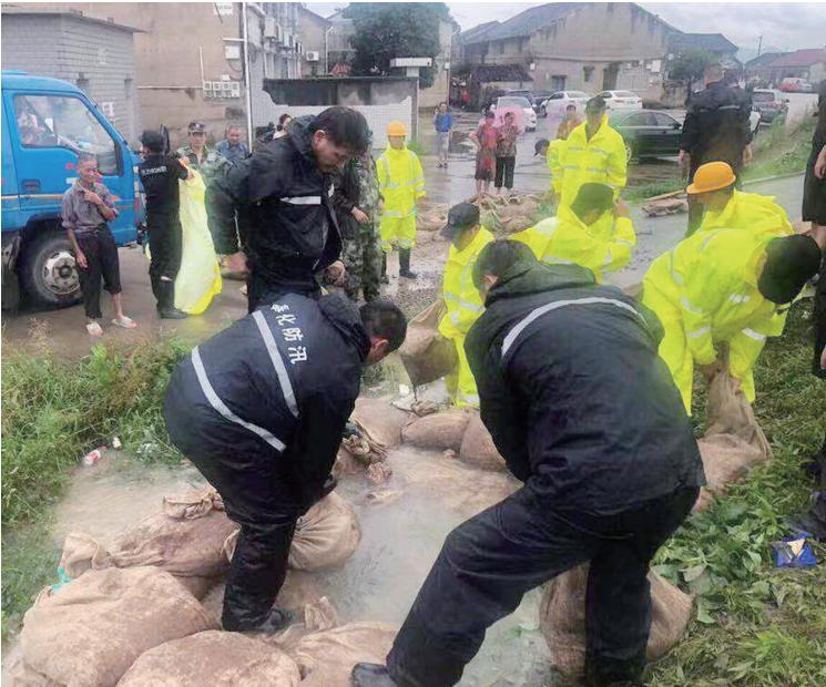
水利系统工作人员对东江堤防渗漏作应急处置。
