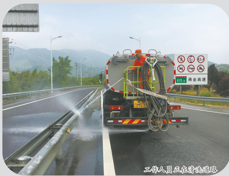
溪南线罩面工程施工现场
