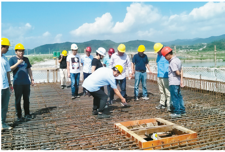
检查沿海农村联网公路(石沿段)现浇梁板浇筑施工情况
