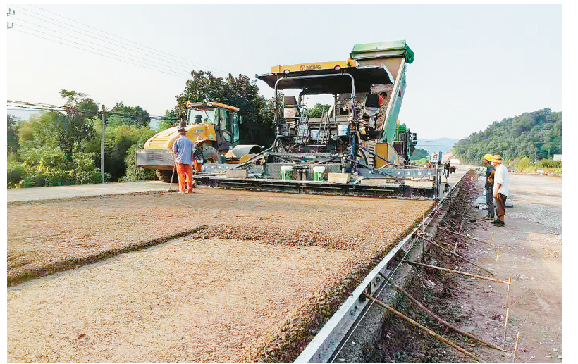
检查甬金高速至生态公路连接线工程路面基层施工情况
