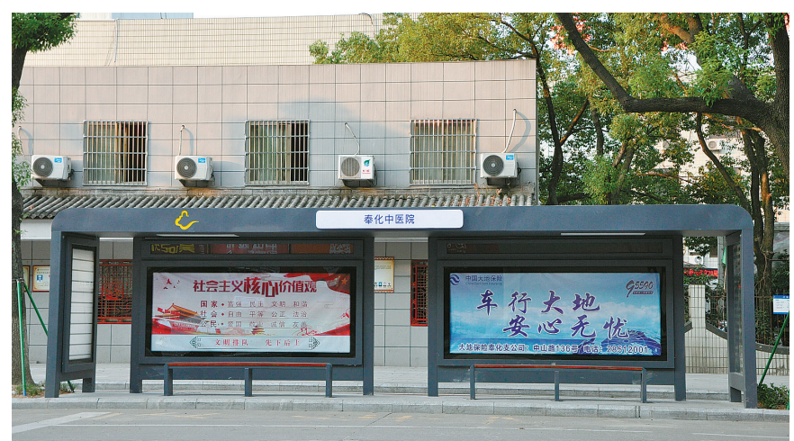
图为新改造的中山路中医院站公交候车亭。
