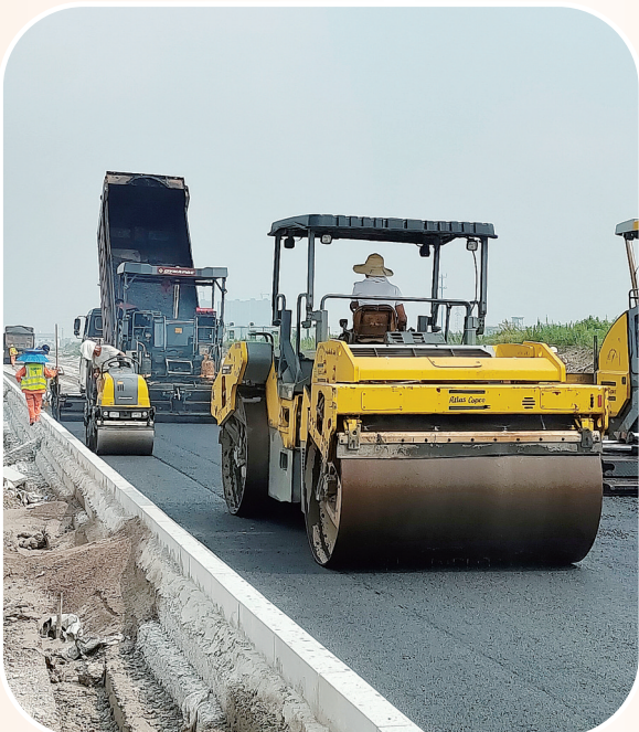
沥青路面施工标准化推进品质工程建设
