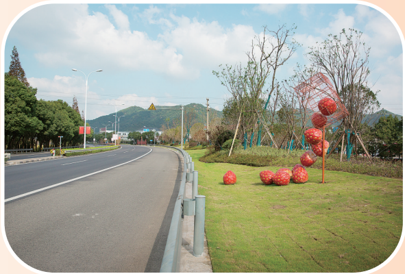
甬临线道路改造提升
