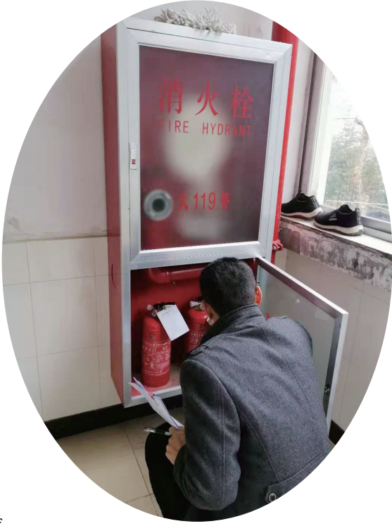
检查萧王庙敬老院安全隐患
