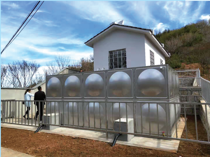
▲溪口镇兰峰村水厂改造后新姿
