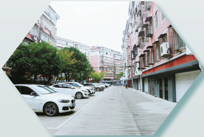
▲ 改造后的桃源小区
