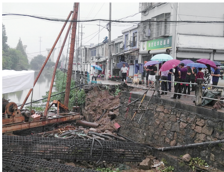
代表视察民生实事项目——沈鲍危桥施工工地
