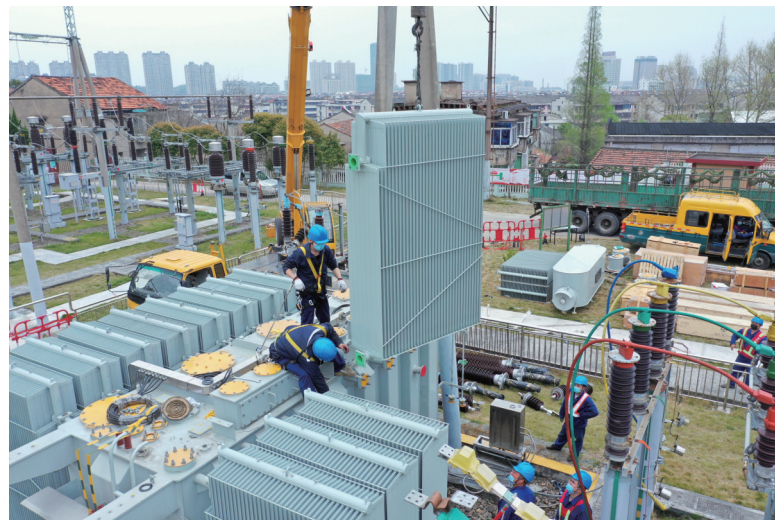
图为110千伏大桥变综合改造现场。
