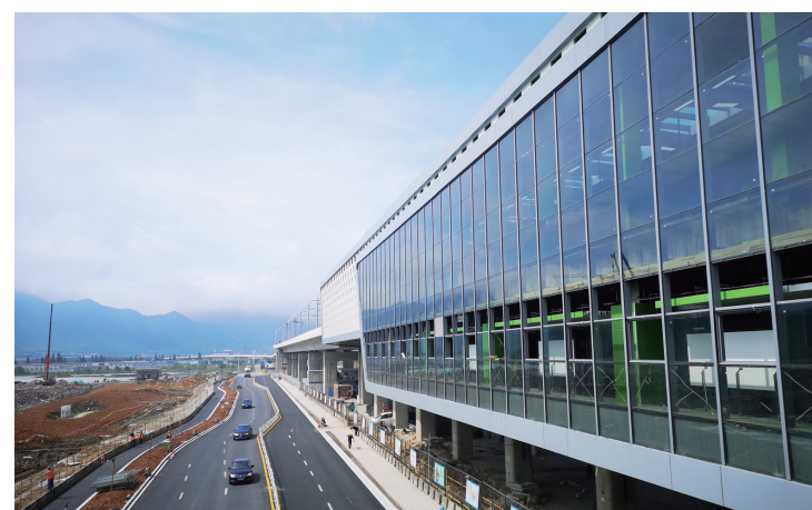
金海站加速建设中
