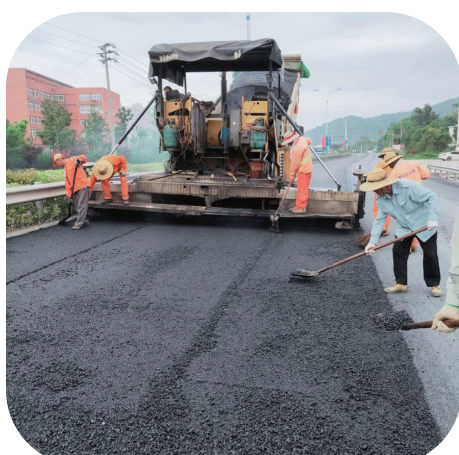
沿海中线沥青罩面施工
