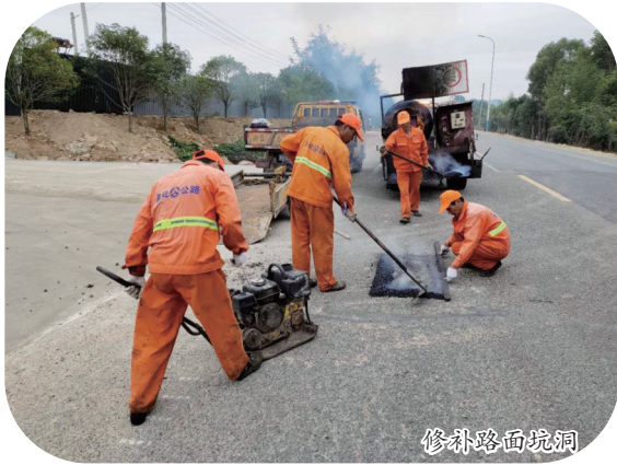
修补路面坑洞
