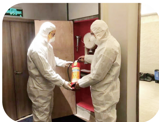
新冠肺炎临时隔离点安全生产和消防安全检查
