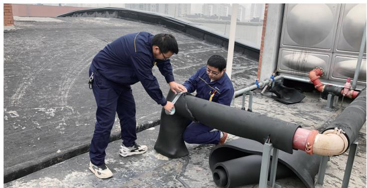
连日来,捷达物业对其服务的几十个物业服务小区、单位、项目的设施设备做好防寒防冻保温措施,以防气温突降造成设施设备损坏。图为工作人员对城市文化中心的水管、水箱、水塔等容易遭受冻害的设施设备采取相应的保温措施。
