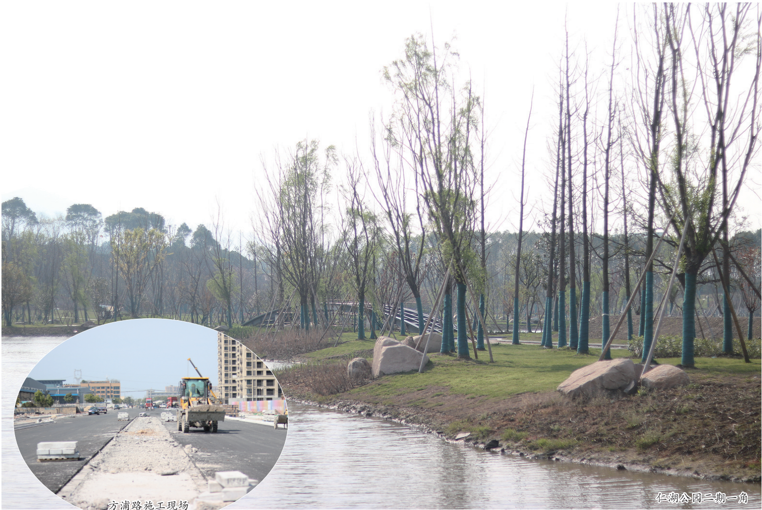
方浦路施工现场
