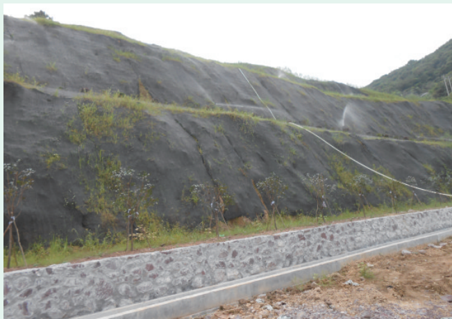
裘村镇黄贤木鱼山废弃矿山生态修复后
