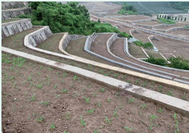
对裘村镇应家棚村肖家坎废弃矿山削坡分层
