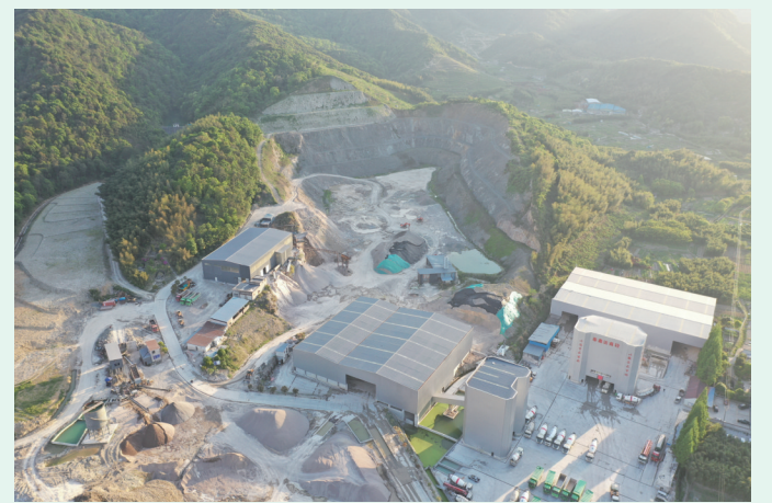
锦屏街道城西采石场现状航拍图
