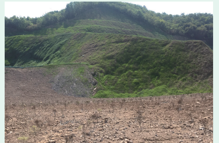
对莼湖街道栖凤村踢倒岩采石场实施边坡喷播
