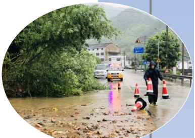
清理塌方路面
