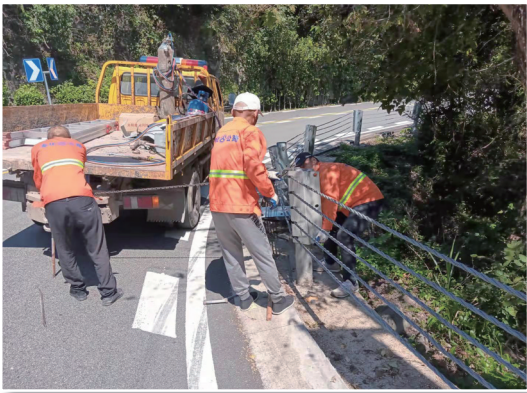
开展节前道路安全设施更换修复
