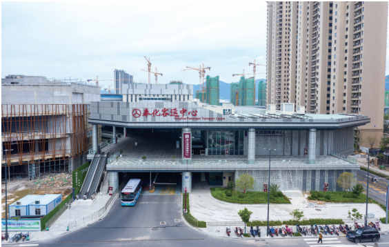
金海路站交通枢纽综合体——随城际铁路同步投入使用
