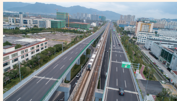
宁奉复合交通走廊项目
