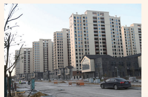
葛香水库安置房项目
