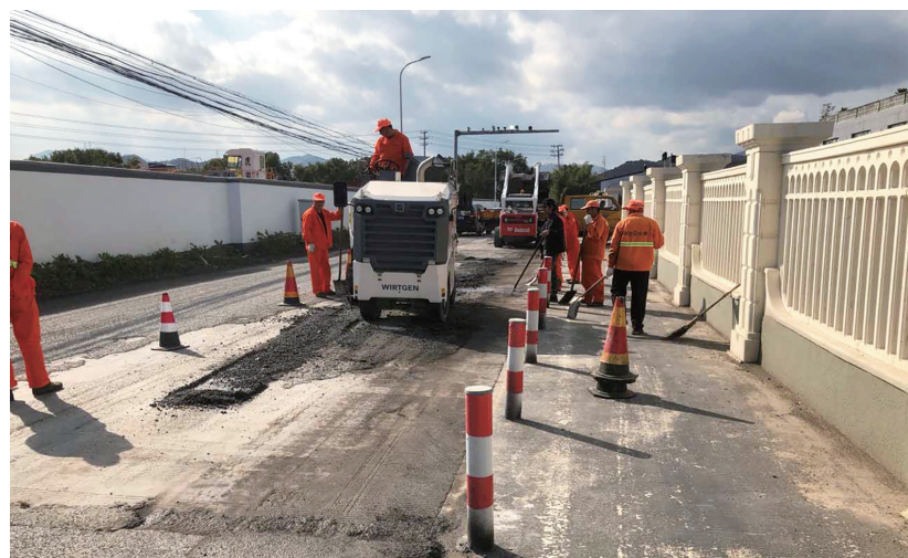
全面开展公路修复工作
