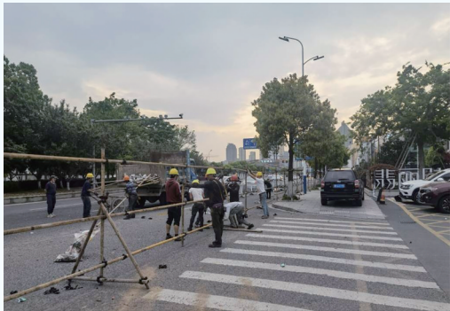
工人正在进行硬隔离钢管围挡作业
