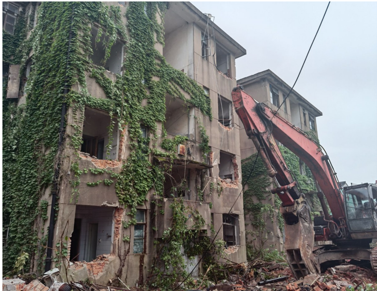
江口街道白雀新村7幢拆除作业
